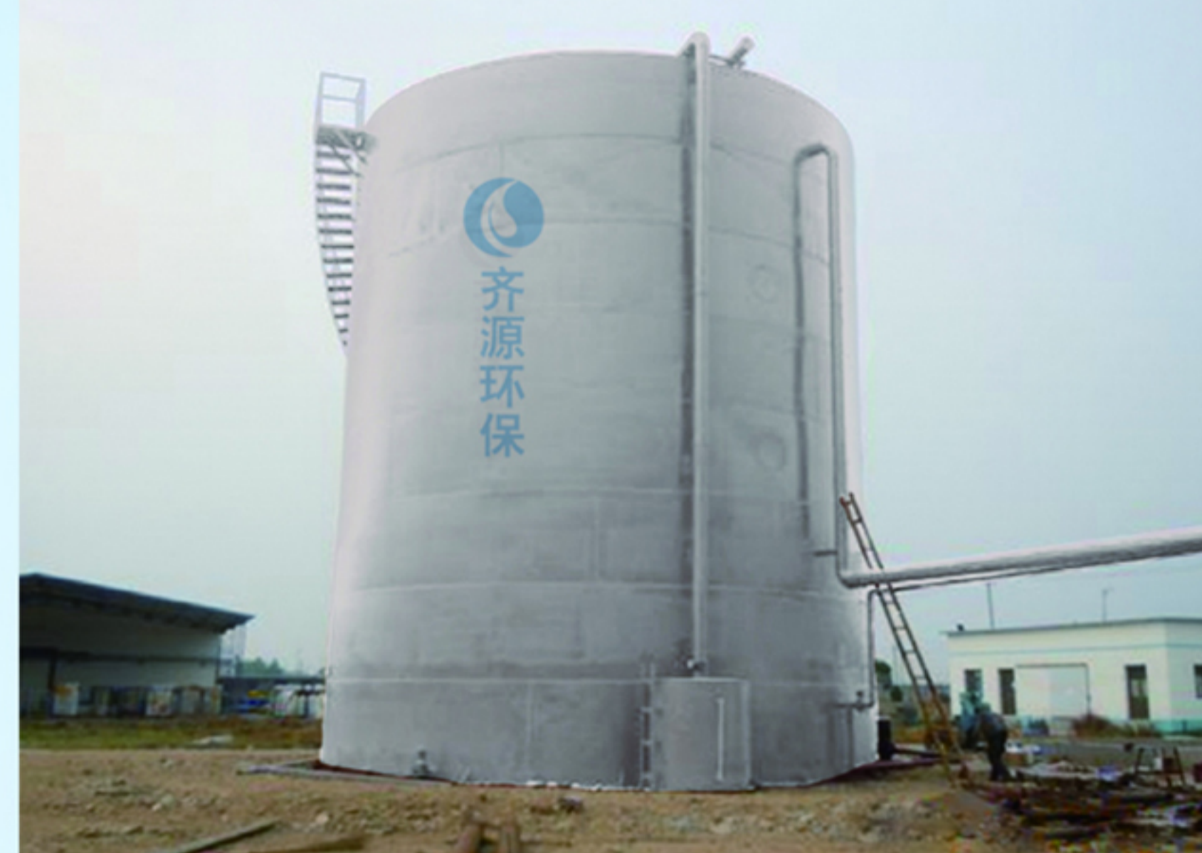
山东天融生物技术有限公司污水处理工程
