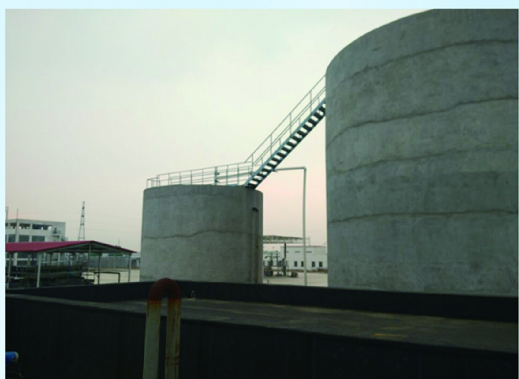
天津承跃新能源有限公司污水处理工程
