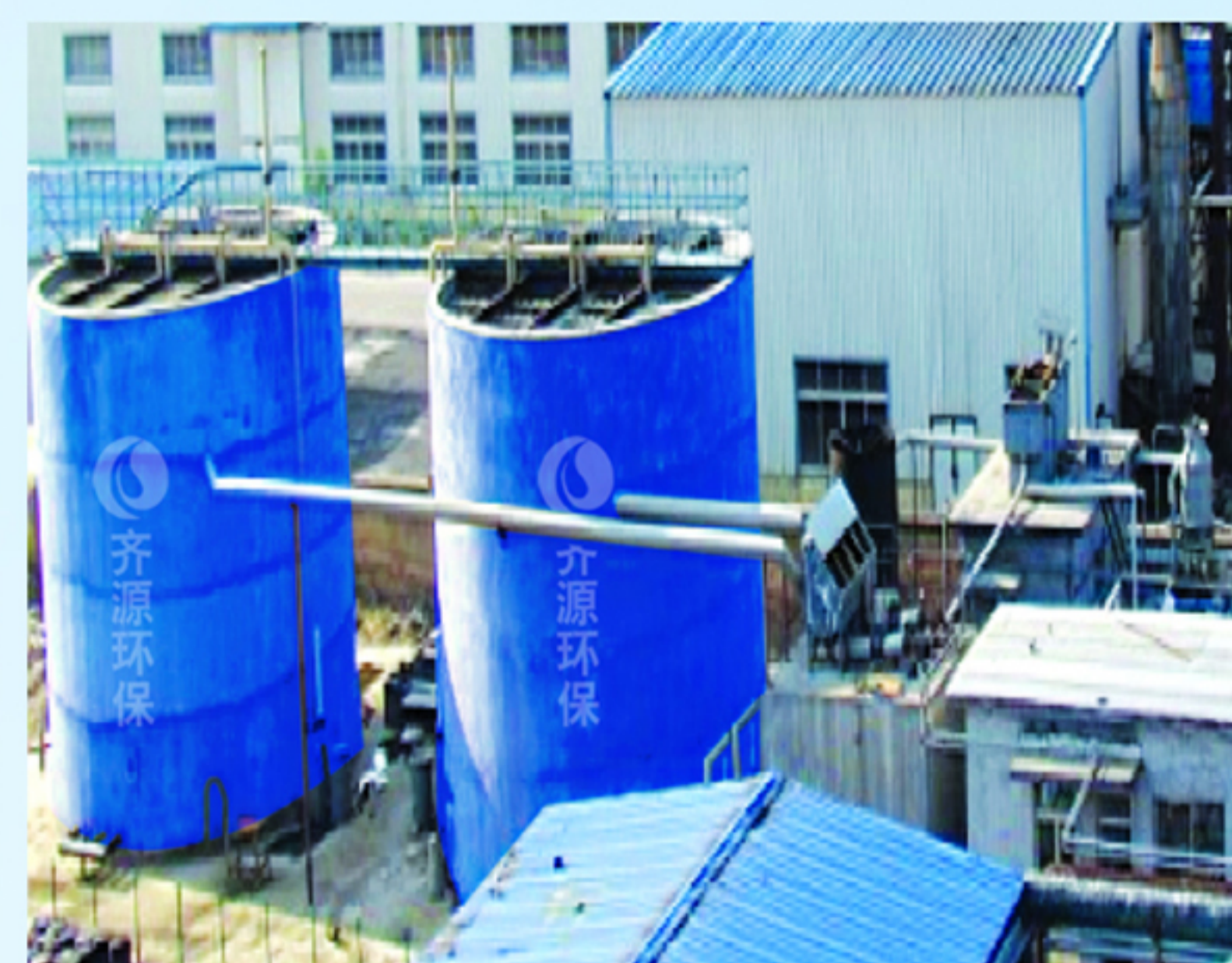
山东华阳油业污水处理工程
