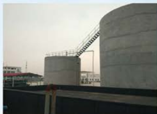
天津承联新能源有限公司污水处理工程
