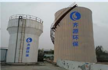
河南亚太新能源有限公司污水处理工程
