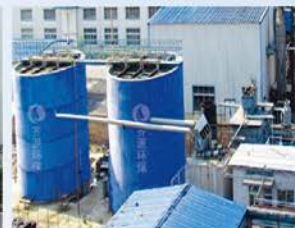
山东华阳油业污水处理工程
