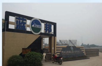
四川蓝邦新能源有限公司污水处理工程
