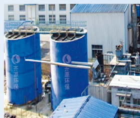
山东华阳油业污水处理工程
