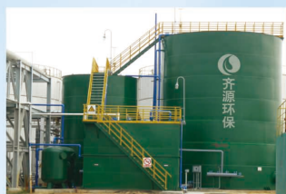
中海油海南生物能源化工有限公司污水处理工程
