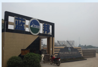
四川蓝邦新能源有限公司污水处理工程
