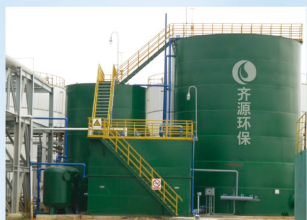
中海油海南生物能源化工有限公司污水处理工程
