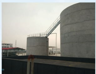
天津承跃新能源有限公司污水处理工程
